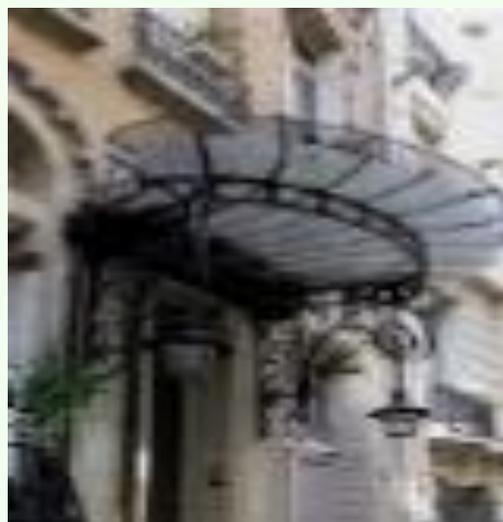
prefabbricati è sufficiente, solitamente, sostituire la parte che presenta il danno, o intervenire per la riparazione. Onde evitare qualsiasi tipo di problema, è comunque consigliabile provvedere periodicamente alla stesura di un nuovo strato di apposita vernice protettiva, soprattutto sulle parti più esposte della tettoia.
