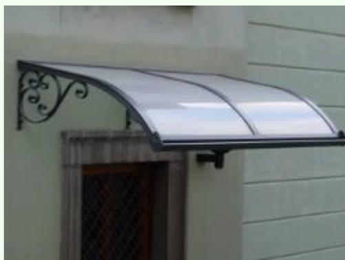
trattazione. Le lastre in plexiglass sono delle vere e proprie strutture modulari, deformabili in fase di lavorazione per assumere la forma desiderata dal cliente, da quella piana a quella a onda, tipica delle pensiline da ingresso. Le pensiline e le tettoie in plexiglass di piccole dimensioni poggiano su telaio in alluminio verniciato con polveri epossidiche e disponibile in vari colori. Le piccole pensiline in plexiglass
