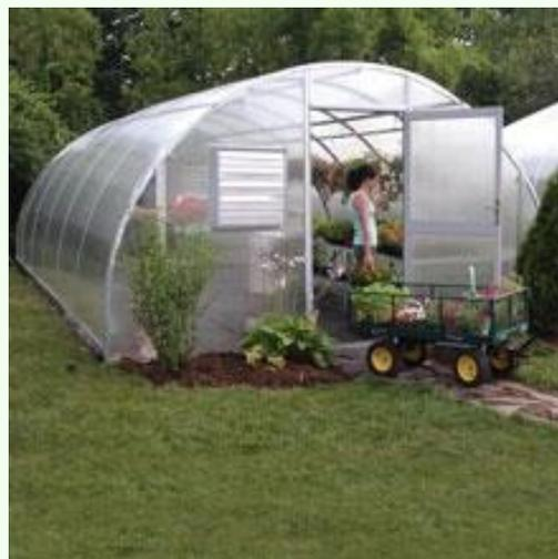
tubolari da 32 millimetri, da ancorare alla fettuccia in cemento.
