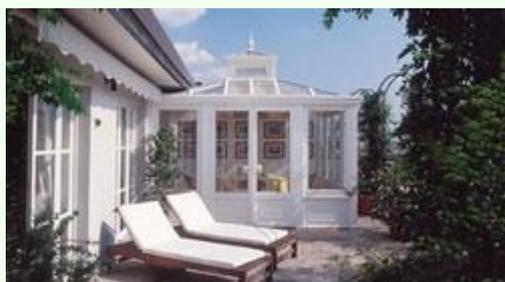
In estate naturalmente il compito della serra bioclimatica è semplificato dalla maggiore irradiazione solare, e generalmente le serre sono state comunque concepite più per un funzionamento invernale, quando vi è maggiore necessità di trattene il calore e aiutare il riscaldamento interno. D'estate invece, nelle ore diurne, si potrebbe incontrare l'effetto contrario, specialmente a latitudini calde, e quindi provvedere a
